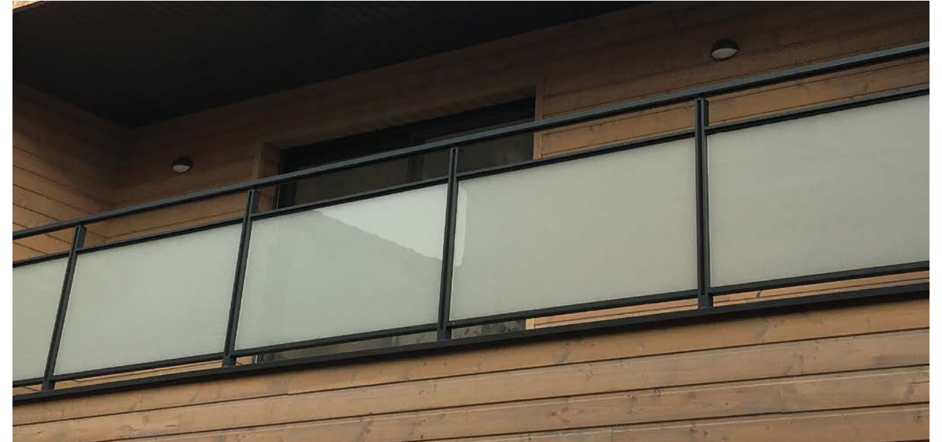
Remplissage sous lisse intermédiaire. Vitrage gris. Pose sur dalle. RAL 7035.
