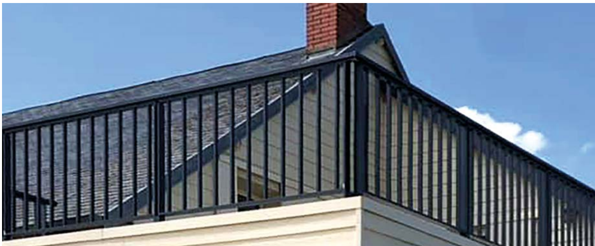
Barreaudé sous main courante. Pose en nez de dalle intérieur. RAL 9005.
